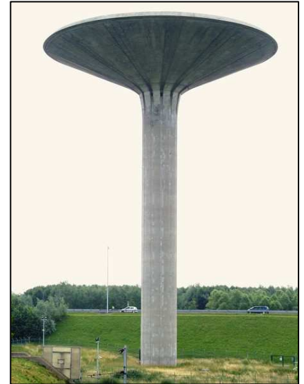
Figure 1 : château d'eau à l'aéroport Charles-de-Gaulle
